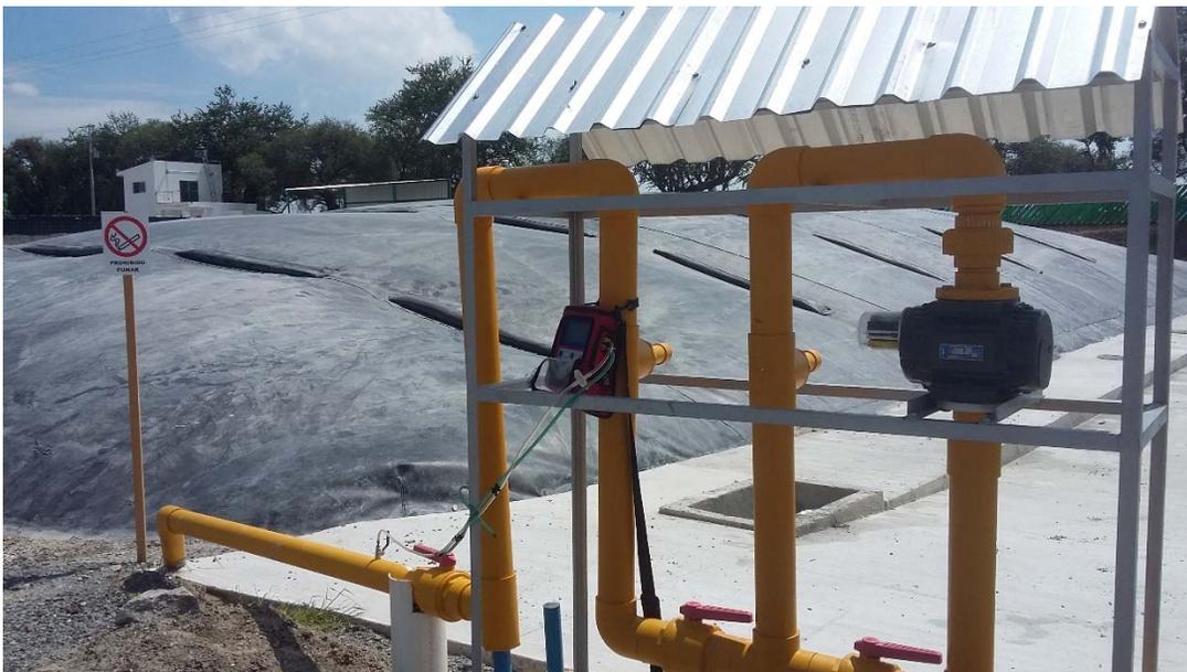
*Ilustración 7 Uso de biodigestores industriales para la generación de biogás y producción de energía eléctrica.*
